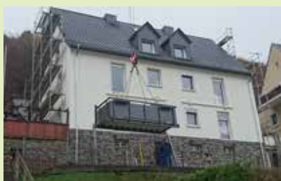
Auch 2017 werden neue Balkone in den Quartieren der ABG angebracht.
