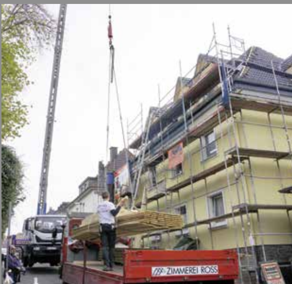
Im kommenden Jahr modernisiert die ABG bis zu 80 Wohnungen.
