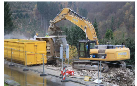
Die Abrissarbeiten wie in der Wilhelmstraße gehen auch 2016 weiter.
