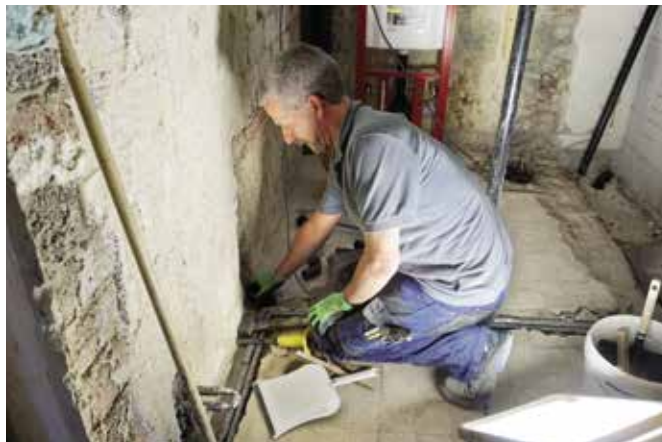
80 Wohnungen werden umfangreich saniert.
