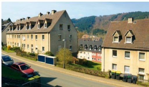
Diese Häuser in der Mozartstraße am Breitenhagen werden in diesem Jahr energetisch saniert.
