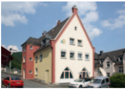
Weitere ABG-Häuser am Knerling bekommen neue Fassadenanstriche – die Gustav-Selve-Straße 2 erstrahlt bereits seit 2013 in neuem Glanz.
