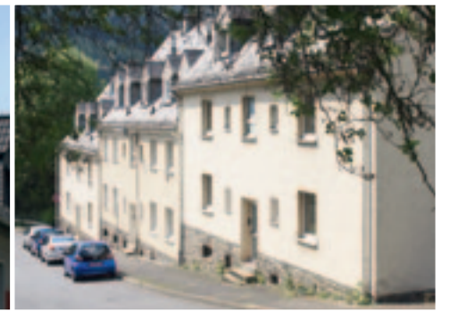
Diese Häuser in der Wilhelmstraße am Breitenhagen werden noch in diesem Jahr zurückgebaut.
