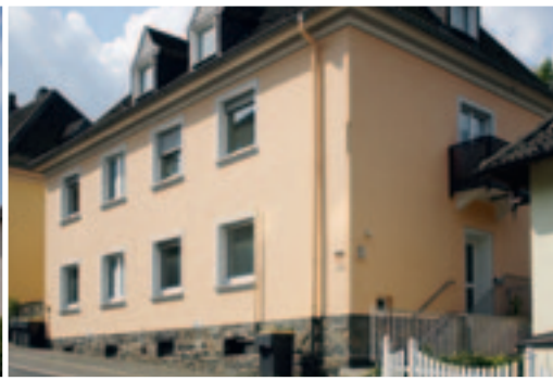
Das Haus Gartenstraße 36 wird komplett saniert und erhält sowohl Balkone als auch einen Aufzug.
